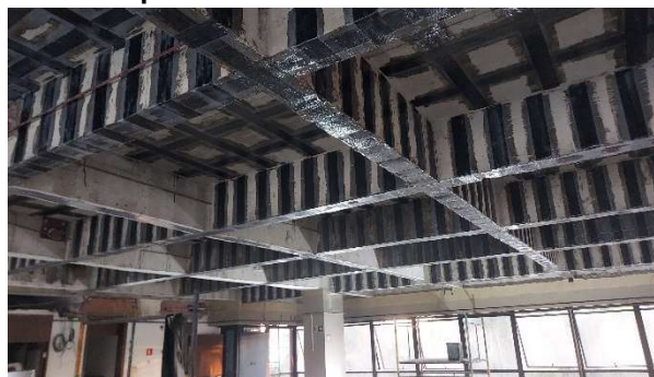
Imagem 2 – Execução de fibra de carbono no 5º pavimento do edifício anexo
