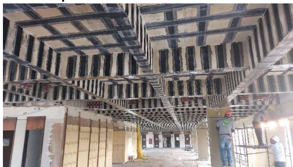
Imagem 1 – Execução de fibra de carbono no 4º pavimento do edifício anexo
